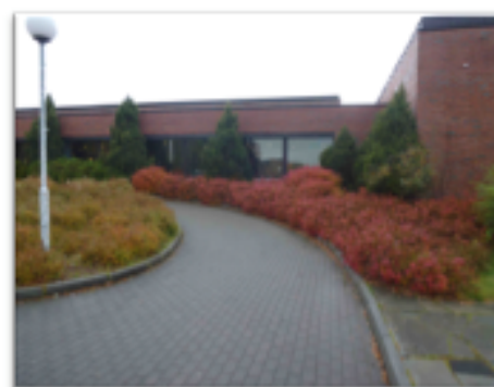
Godt synlig og taktil avgrensning av gangbane til inngang. En godt synlig og følbare kant mellom asfalt/grus og gress er tilstrekkelig.
