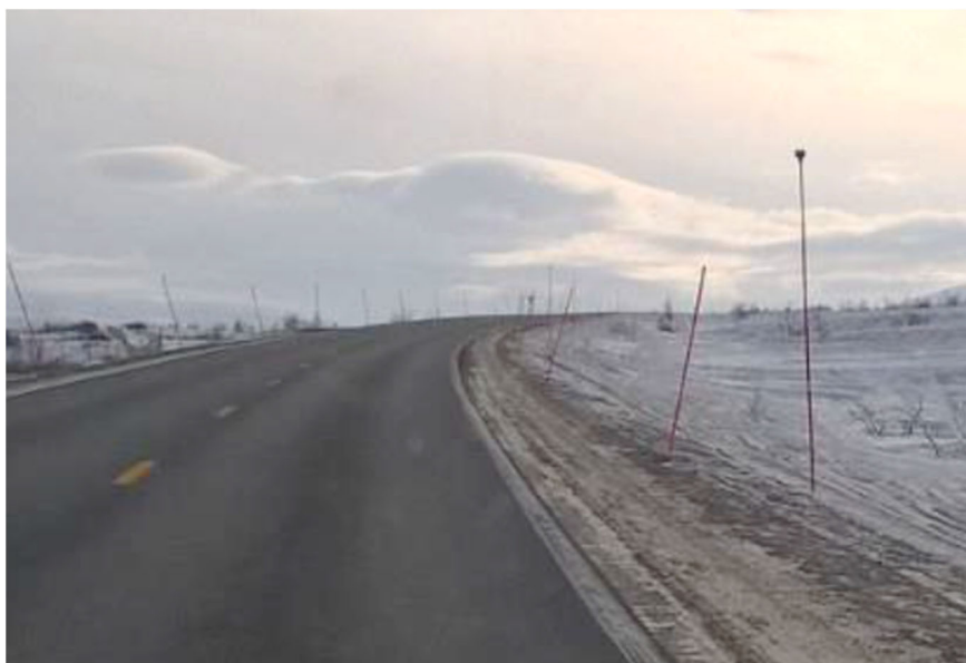
Figur 4. Jernstikker langs veien påmontert mottaker med blinklys. Foto: Svein Morten Eilertsen.
