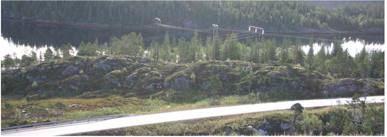
Bilde 1. Eksempel på tekniske inngrep, 3 kraftlinjer og vegen som går gjennom flyttleia ved Brønnøy Kalk
